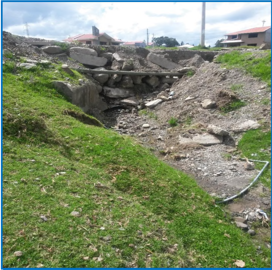
Fotografía 7: Desfogue de corriente de agua que proviene del sub suelo de la zona Elaborado: Byron Quezada Fecha: Agosto 2015
