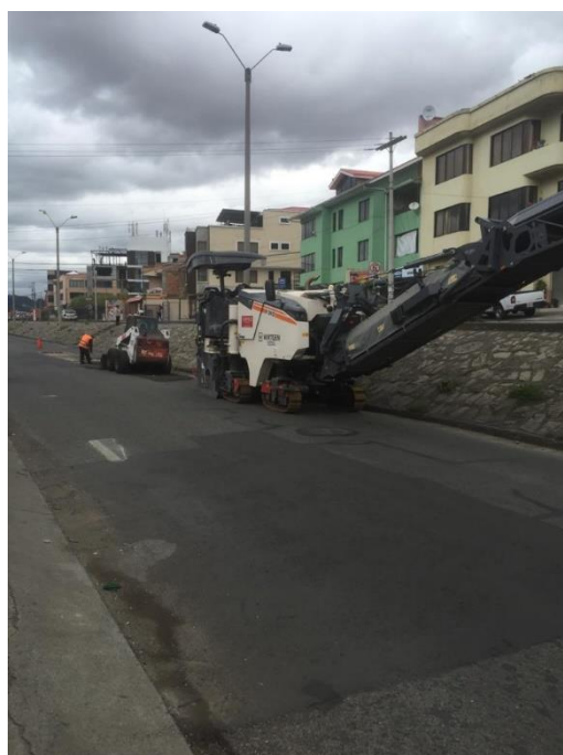
- Muestra 7: Fresado con fresadora – Av. González Suárez.
