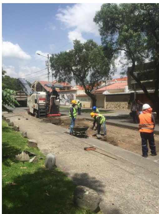
- Muestra 8: Fresado con fresadora – Av. 27 de Febrero y Arturo Valencia.
