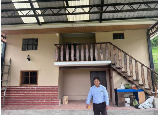
Figura 18: Imagen vivienda de Ladrillo
