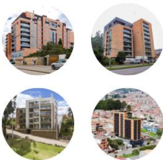
Figura 35: Conjuntos Residenciales de Cuenca.
