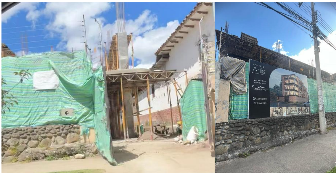
Figura 25: Vista frontal del Edificio Ariis en construcción – Sector Yanucay.
