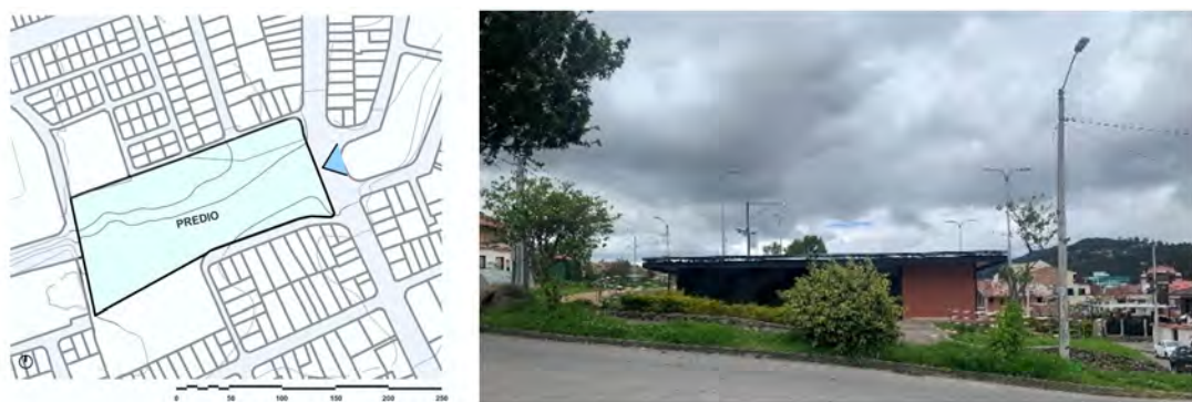
FIGURA 4.15: Vista del Centro Comunitario Monay dentro del parque la Espera Nota: Vista hacia el terreno desde la calle Pancho Villa. Elaboración propia
