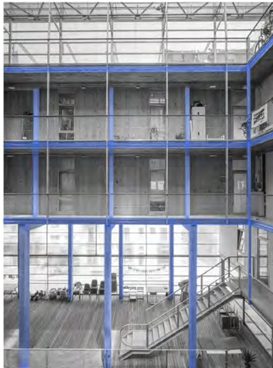
FIGURA 2.14: Tecnología Estructural, La Borda Lacol Nota: Elaboración propia adaptado de Lacol y Millares (2018) .
