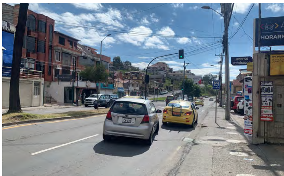
FIGURA 4.35: Vista frontal del terreno, calle Pancho Villa
