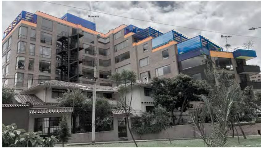
FIGURA 3.15: Remate del Conjunto Habitacional "Terrazas al Río"
