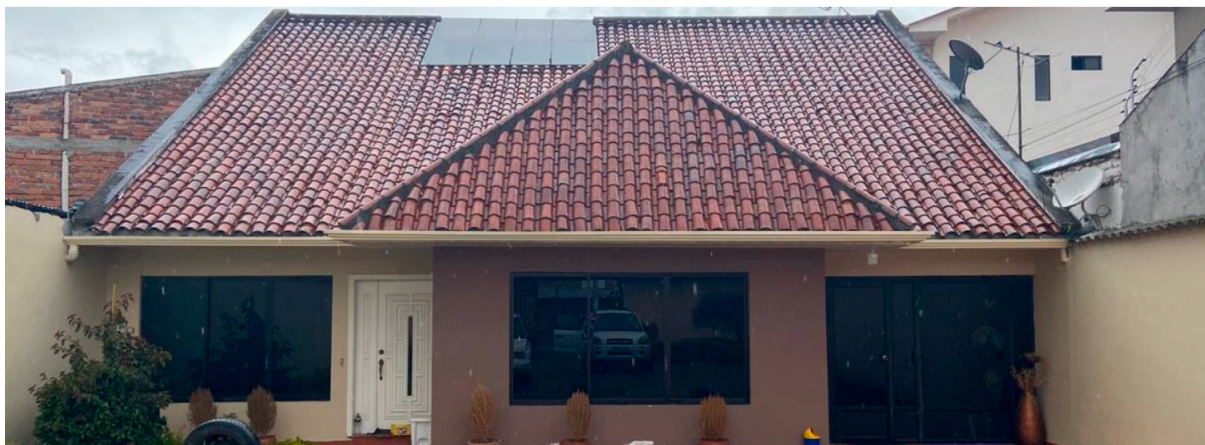
FIGURA 4.16: Fachada norte de la vivienda de análisis del periodo 2.
