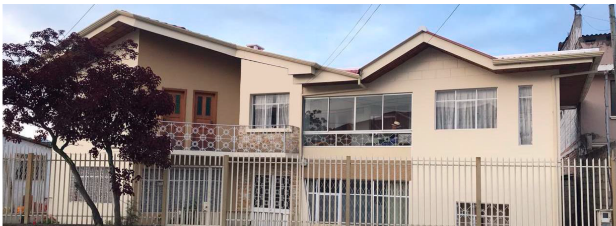
FIGURA 4.5: Fachada norte de la vivienda de análisis del periodo 1
