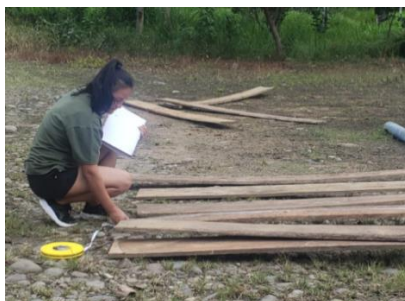
Figura 15: Medición de las tablas para la adecuación de las pilas
