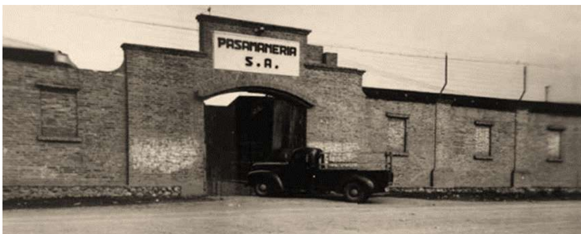
Figura 2.8: Muro exterior de la fábrica Pasamanería S.A junto a la carretera Norte ahora llamada Huayna Cápac
