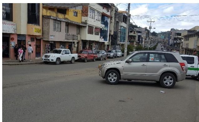
Fotografía 3: Falta de dispositivos (semáforos).
