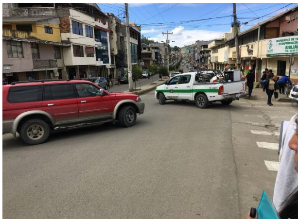
Fotografía 11: Falta de señalización. paradas.
