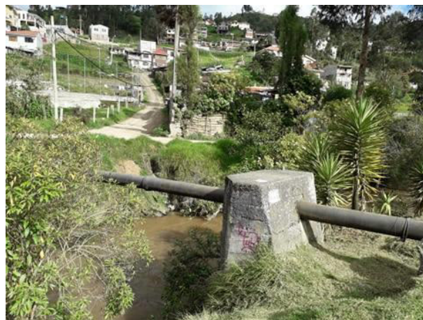
Gráfico 17. Viviendas que vierten sus aguas en los cauces del río Fuente: Propia
