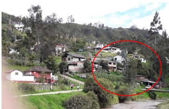
Gráfico 22. Puente de madera que sirve de conexión [Fotografía]. Fuente: Propia
