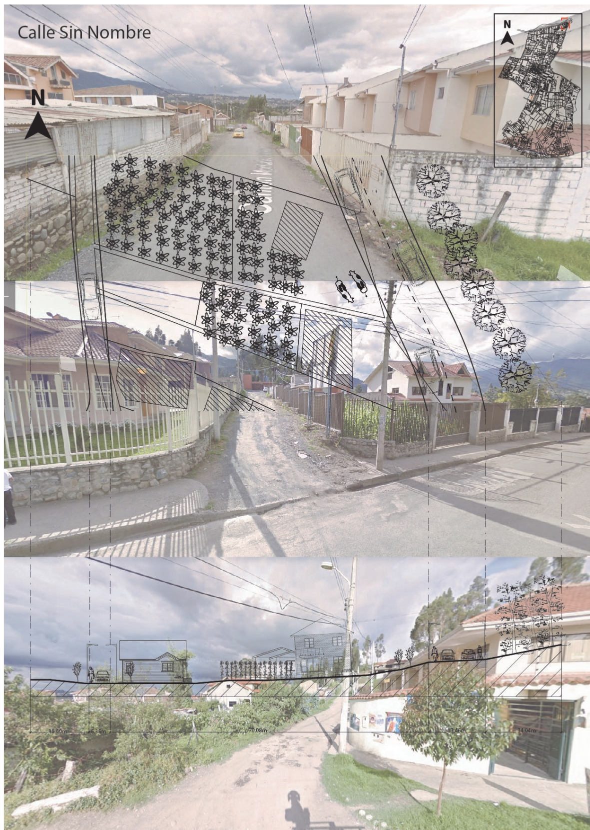
FIGURA 2.32: Sección del sector de Misicata. Calle deteriorada y sin veredas. Fuente: earth.google.com, elaboración: propia.
