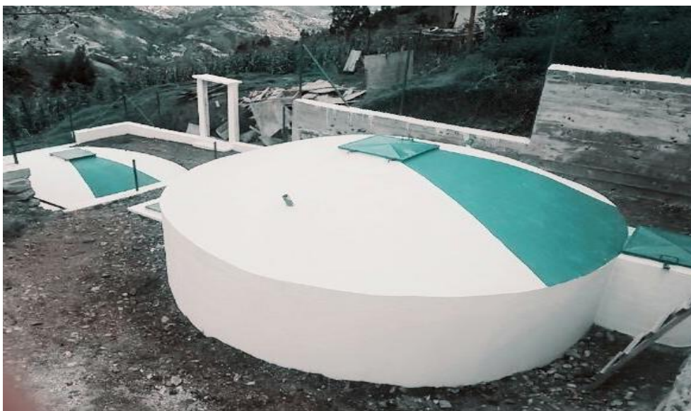
Fotografía 2: Tanques de agua entubada de la comunidad de San Pablo. Fuente: El Autor.
