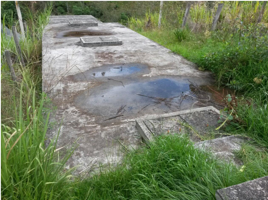
Fotografía 7: Esquema de la planta de tratamiento de aguas residuales. Fuente: El Autor.
