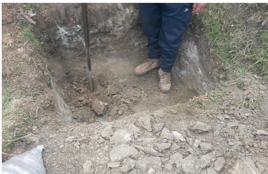
Fotografía 3: Excavación para toma de muestra del suelo. Fuente: El Autor.
