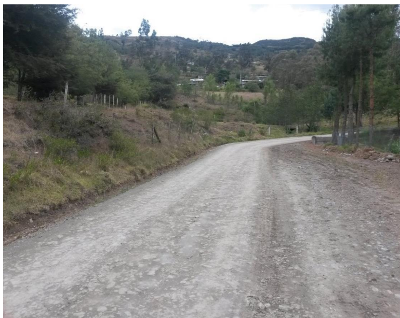
Fotografía 1: Estado de la red vial de la zona del proyecto.
