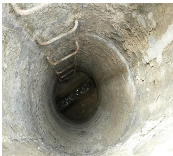
Fotografía 6: Inspección del pozo # 21. Fuente: El Autor.
