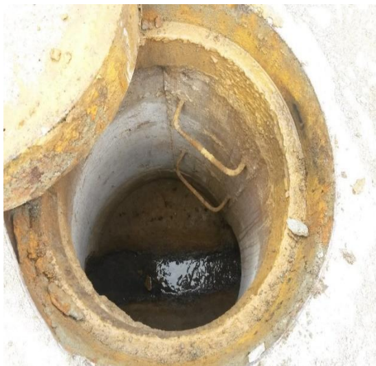
Fotografía 5: Inspección del pozo # 13. Fuente: El Autor
