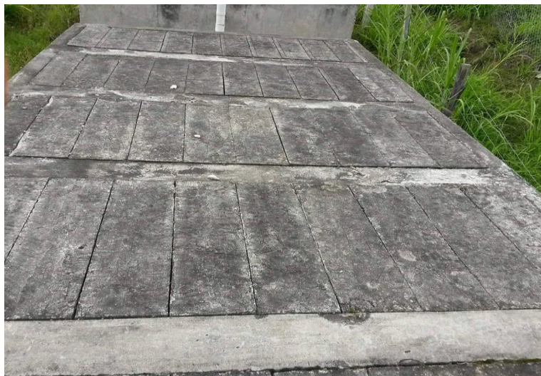
Fotografía 10: Filtro anaerobio. Fuente: El Autor.
