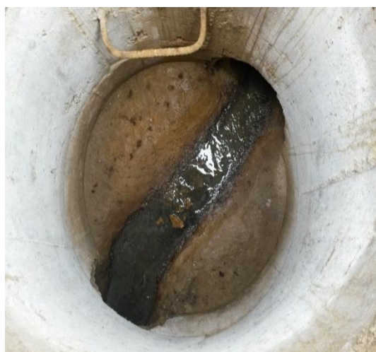
Fotografía 4: Inspección del pozo # 9. Fuente: El Autor.
