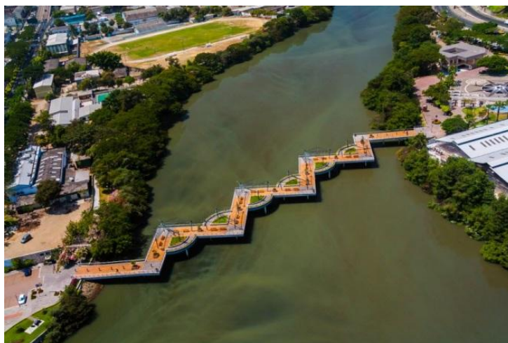
Figura 11: Vista aérea del Puente Zig Zag sobre el Estero Salado, Guayaquil – Ecuador.
