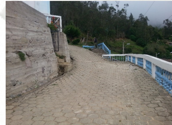
PRIMER Y SEGUNDO TRAMO DE VÍA DE ACCESO AL CEMENTERIO
