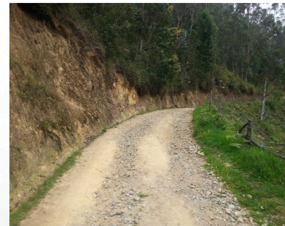
TERCER TRAMO DE VÍA DE ACCESO AL CEMENTERIO
