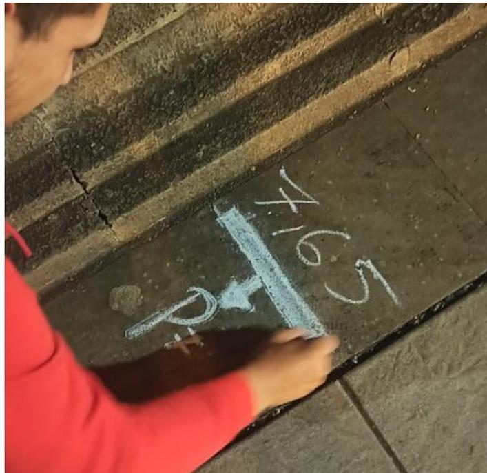
Figura 36 Marcado de puntos con tiza
