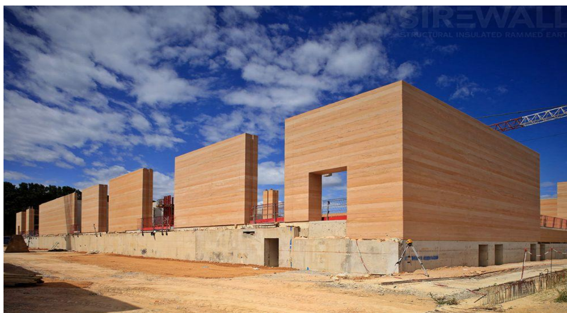
Figura 14. Construcción en tapial, Museo de Historia de Narbo Via
