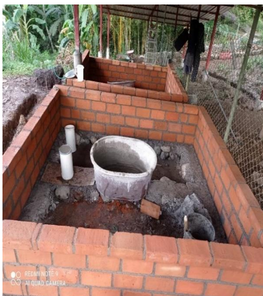
Figura 6. Construcción de composteras.
