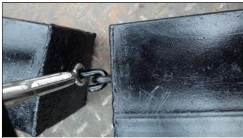
Ilustración 63. Pesos de soporte para estabilizar la estructura. Fuente: Autores.
