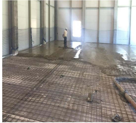
Imagen 11. Uso de HAC en un pavimento
