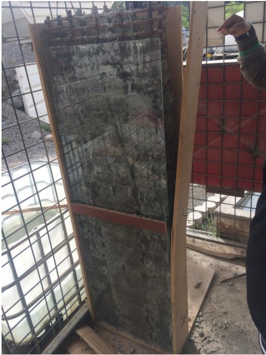
Imagen 76. Desencofrado del muro esbelto con hormigón convencional sin compactar Fuente: Autor
