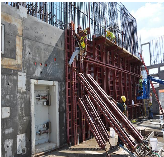
Imagen 5. Muro de gran longitud y alta cuantía de acero
