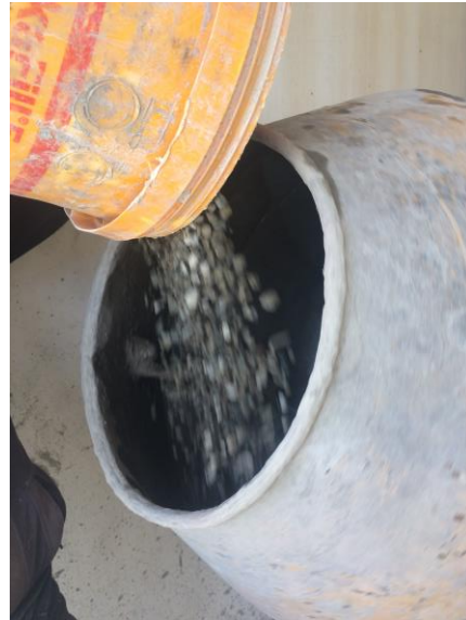
Imagen 37. Colocación de grava en el mezclador Fuente: Autor
