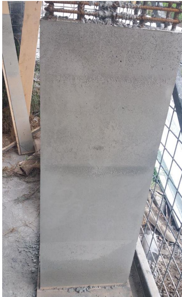
Imagen 31. Muro de hormigón autocompactante Fuente: Autor
