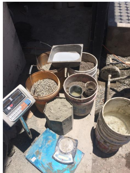
Imagen 35. Dosificación de materiales Fuente: Autor
