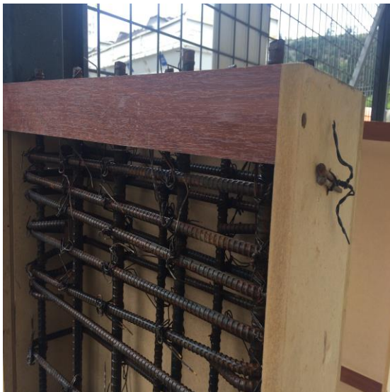
Imagen 66 Centrado de la armadura de refuerzo en el encofrado Fuente: Autor
