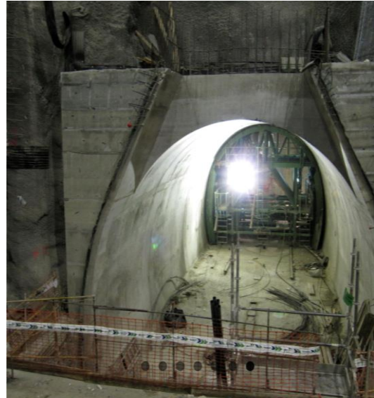
Imagen 13. Terminado de túneles con HAC
