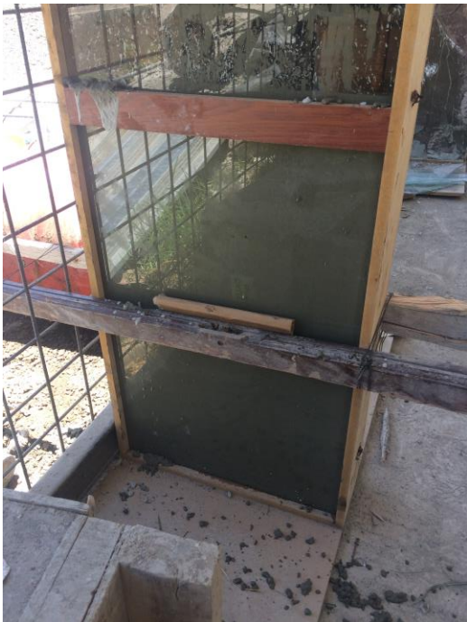
Imagen 74. Hormigón autocompactante en un muro esbelto Fuente: Autor
