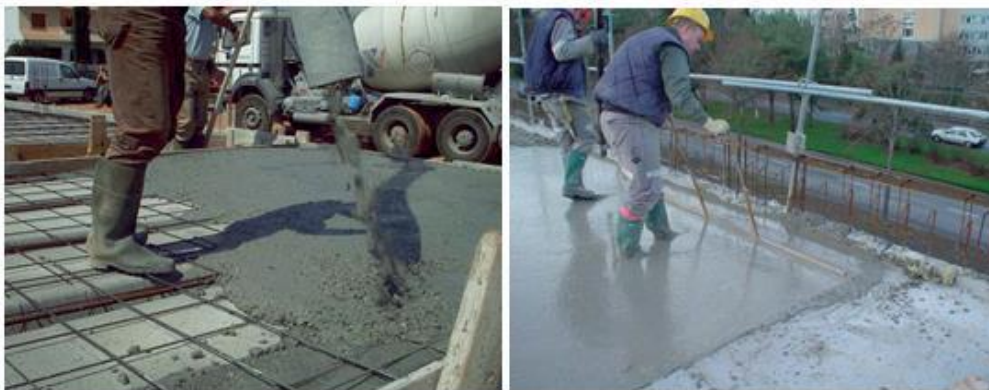
Imagen 9. Las dos Fotos Muestran el Vertido del HAC, Requiere solo 2 Operarios Fuente: El Hormigón Autocompactante, ¿Una Alternativa para la Construcción de Pavimentos Rígidos de Carreteras con el Sistema de Encofrados Fijos?
