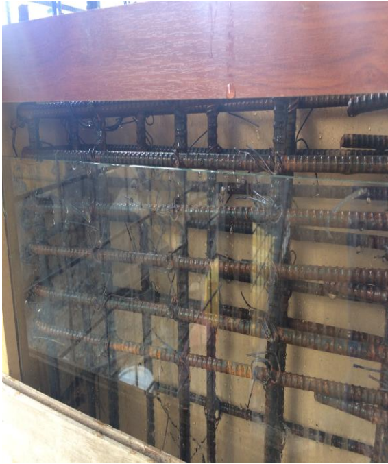
Imagen 68. Encofrado y estructura de refuerzo humedecido Fuente: Autor
