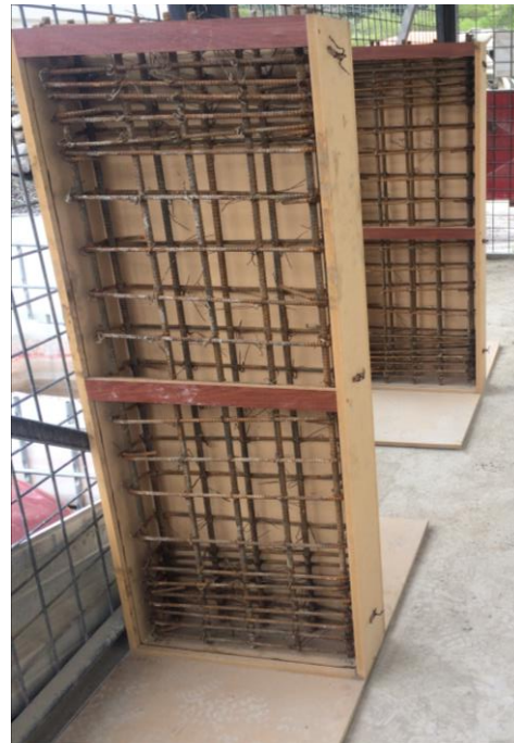
Imagen 26. Encofrados con armadura de refuerzo Fuente: Autor
