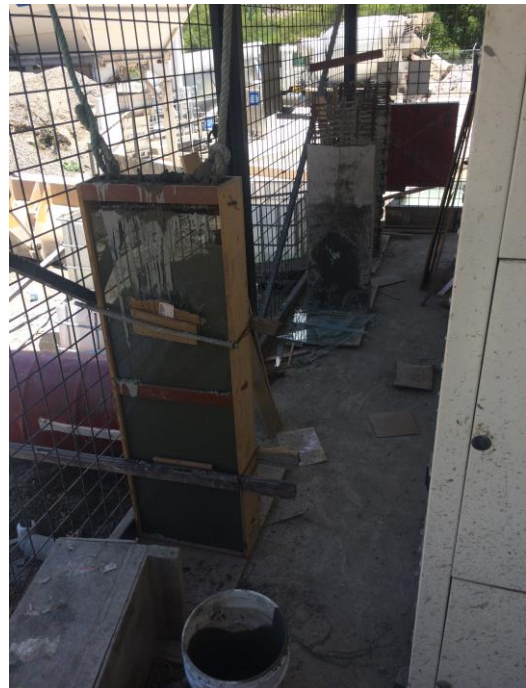
Imagen 75. Resultados del hormigón autocompactante en un muro esbelto Fuente: Autor
