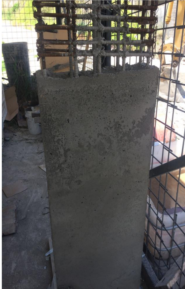
Imagen 30. Muro de hormigón compactado Fuente: Autor
