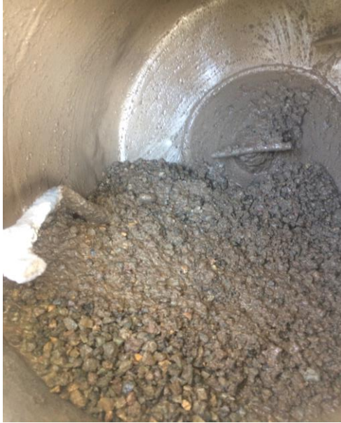
Imagen 40. Mezclado de agua, grava, arena y microsílíce Fuente: Autor
