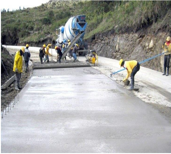
Imagen 10. Hormigón convencional en pavimentos
