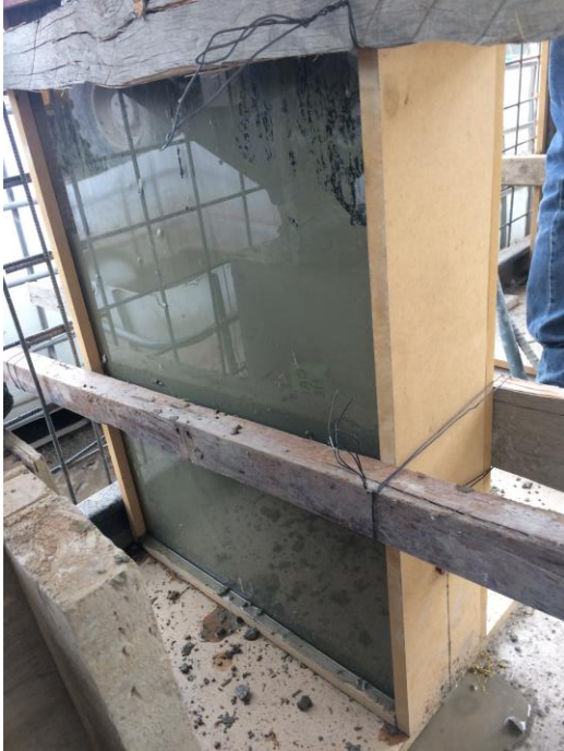
Imagen 72. Hormigón convencional en un muro esbelto compactado Fuente: Autor
