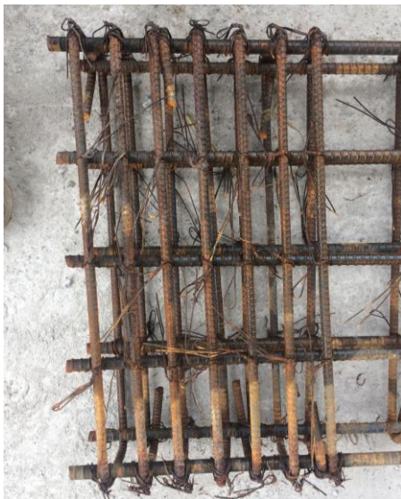
Imagen 27. Separación del refuerzo en los extremos de la armadura de refuerzo Fuente: Autor
