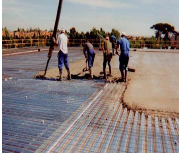
Imagen 8. Vertido de hormigón convencional en una losa, requiere 5 personas.
