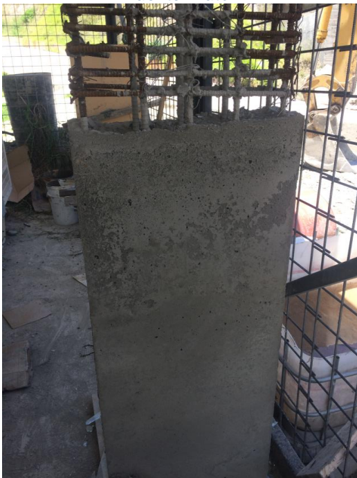
Imagen 78. Muro esbelto con hormigón convencional compactado Fuente: Autor
