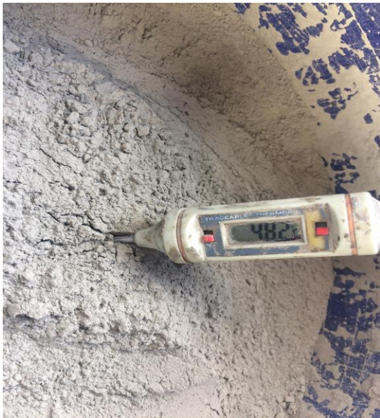
Imagen 62. Toma de la temperatura del cemento Fuente: Autor
