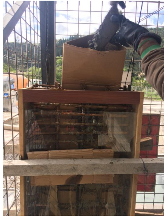
Imagen 69. Colocación del hormigón en el encofrado Fuente: Autor
