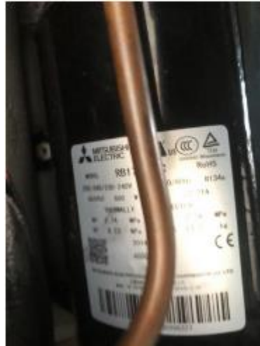
Figura 13. Compresor hermético tipo rotativo Fuente: Centro de Energías Renovables universidad católica de Cuenca
