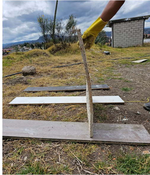
Pandeo del Panel expuesto al fuego durante 10 minutos
