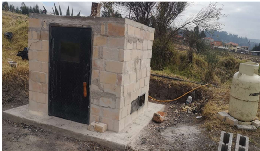
Figura 11. Horno construido para someter paneles a pruebas de fuego
