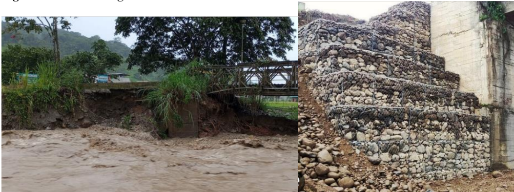
Figura 5.2. Muros de gaviones en el alerón derecho.
