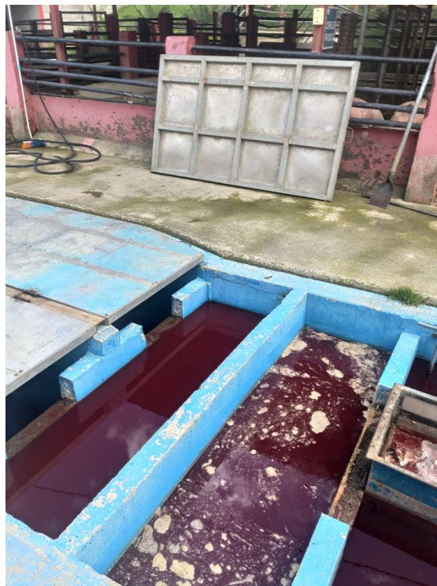
Figura 25 Tanques del Camal de Gualaceo
