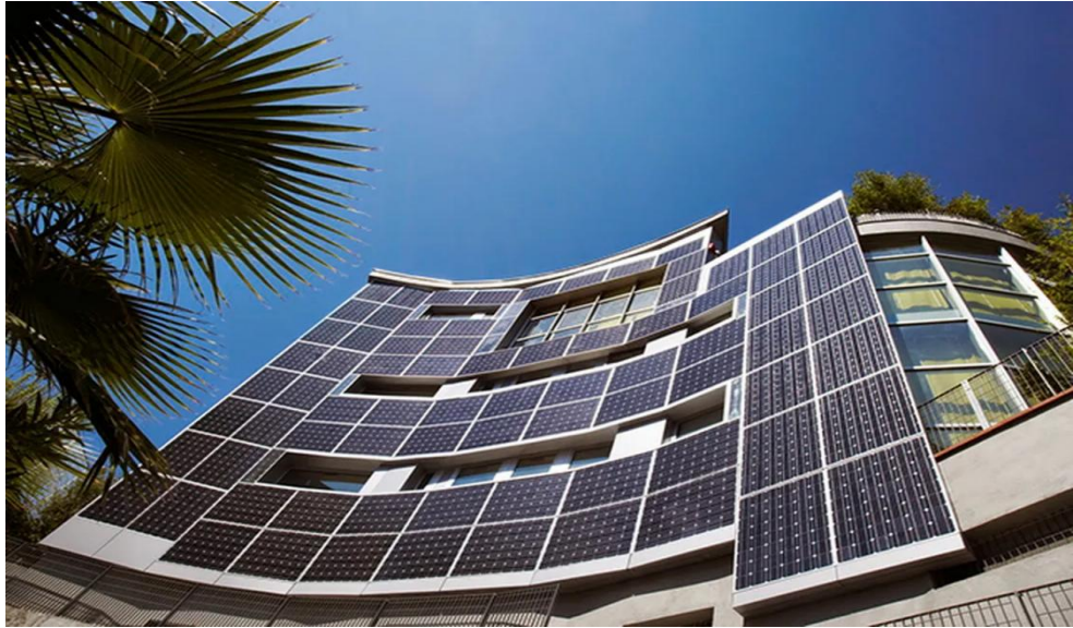
Figura 13: Fachada con paneles fotovoltaicos. Fuente: Eadic (2022)
