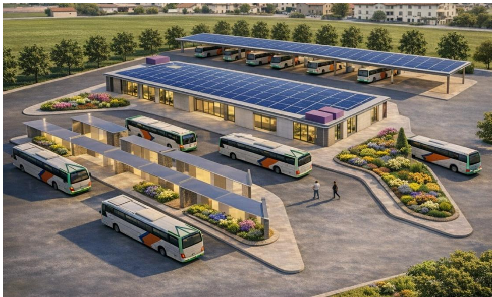
Figura 70: Paneles solares CC – Ricaurte Fuente: Elaboración propia.
