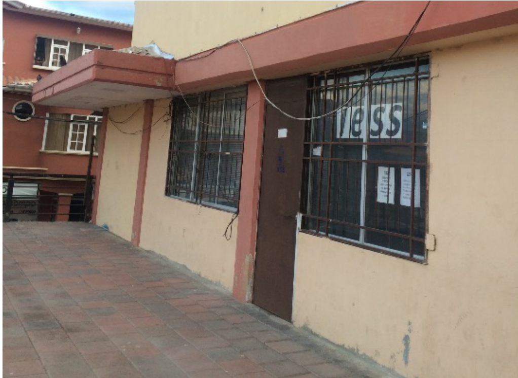
Img. 21 Oficina independiente sin Servicio Higiénico Fotografía tomada por: Steve Palacios T. Fuente: Oficina del IESS
