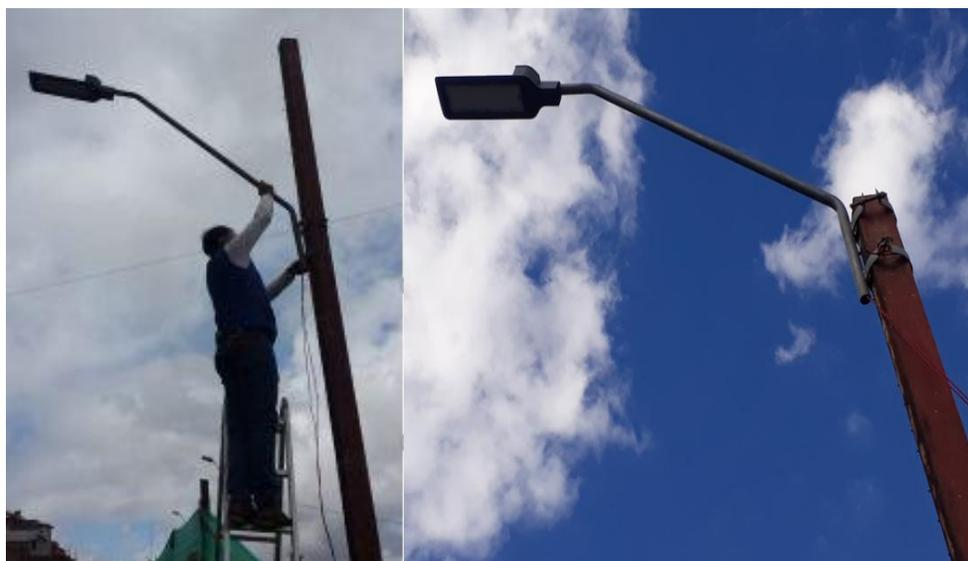
Fig. 43 Montaje de la luminaria con su respectivo brazo para soporte en el poste.
