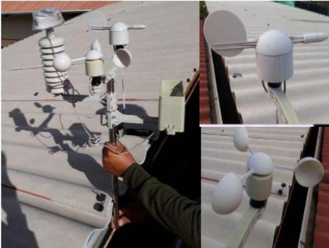
Fig. 32 Colocación de la estación meteorológica con su respectiva Anemómetro y Veleta en el lugar de estudio.
