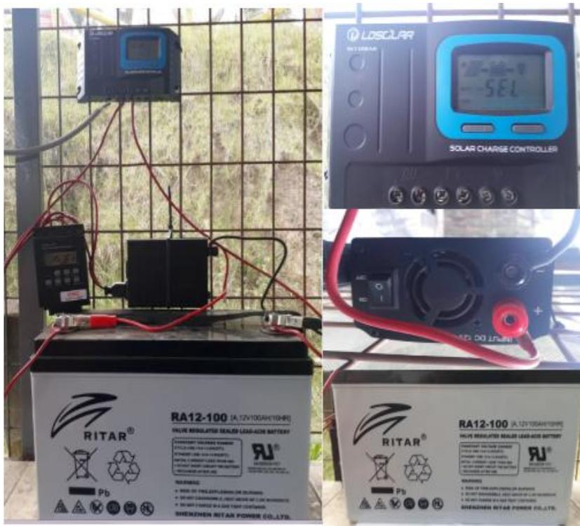
Fig. 41 Montaje de controlador, Batería e Inversor
