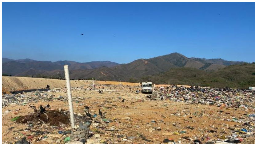
Celda de recepción de desechos, al fondo vehículo de apoyo.
