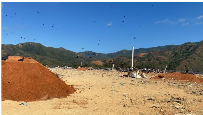
Material de cobertura de residuos.
