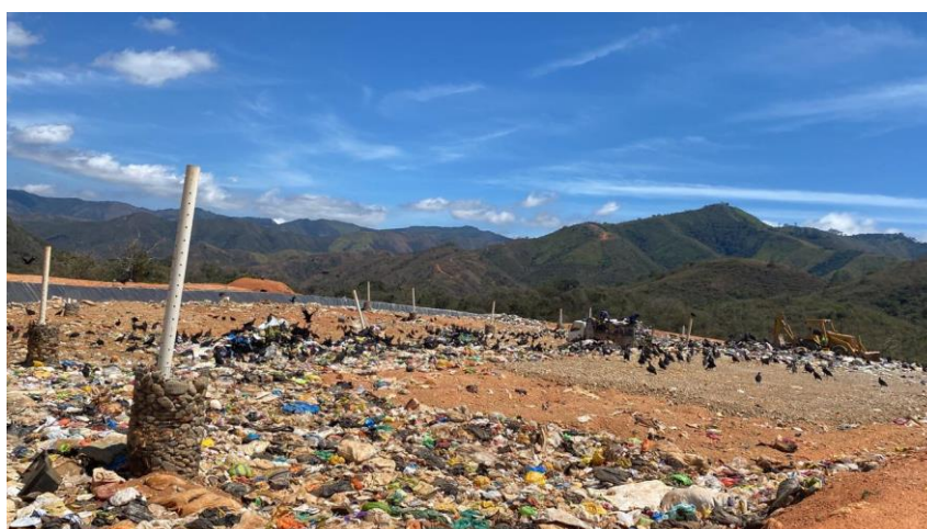
Chimeneas de control de gases.
