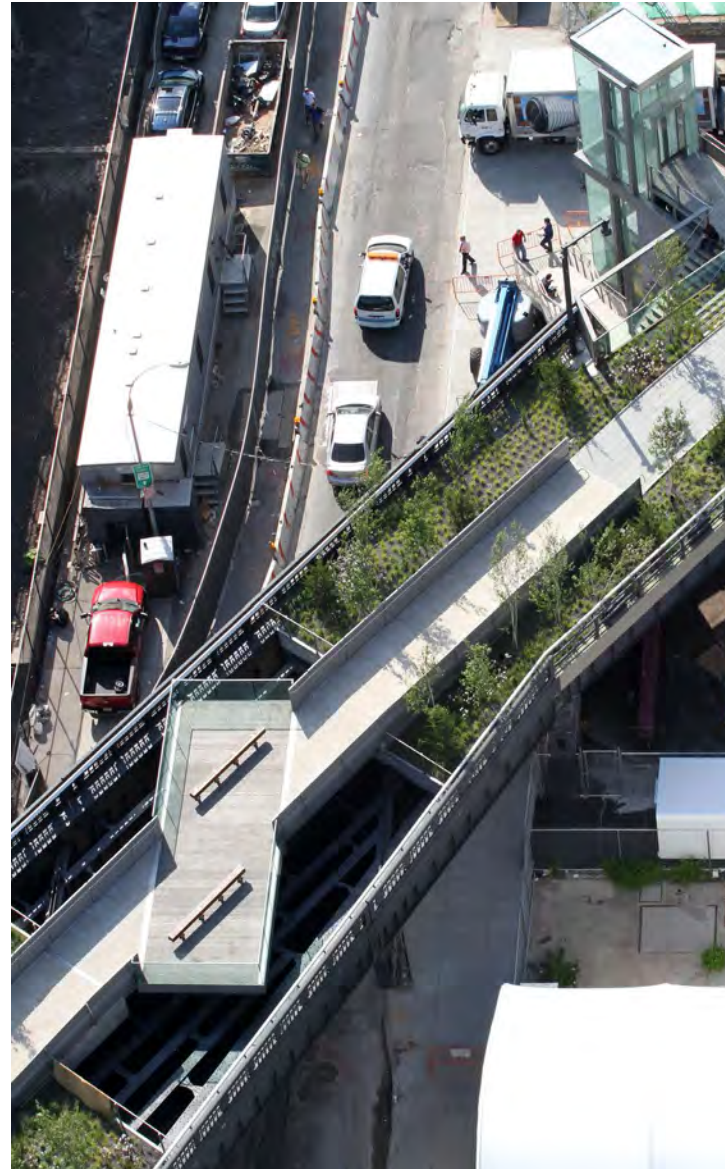
54. Fotografía: Vista aérea de paseo elevado, High Line Park.
