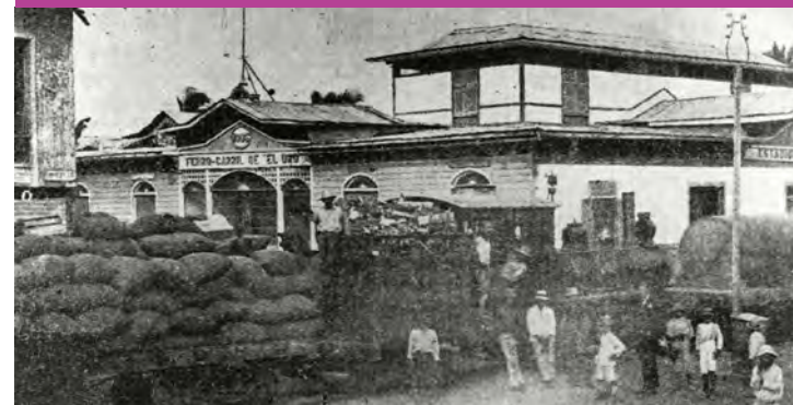
24. Fotografía: Estación de Machala, Línea del Oro.
