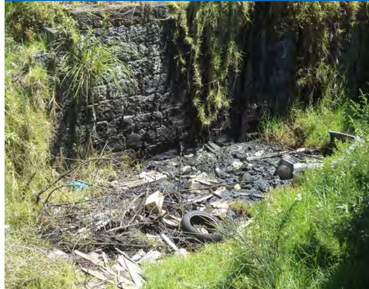
110. Fotografía: Interior de la quebrada contaminada por derrame de aceite y basura.
