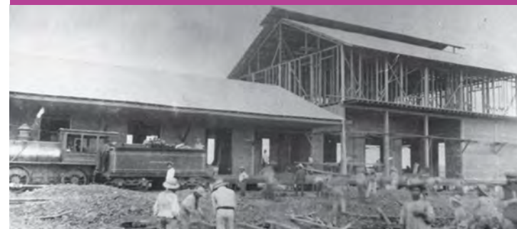
5. Fotografía: Construcción de la estación del tren de Durán.
