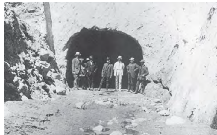
17. Fotografía: Empresarios revisando un túnel.
