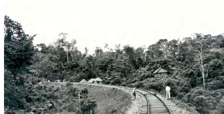
22. Fotografía: Vía Férrea, Línea a la Costa.
