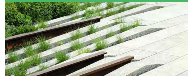
57. Fotografía: Placas de hormigón más vegetación y rieles, High Line Park.
