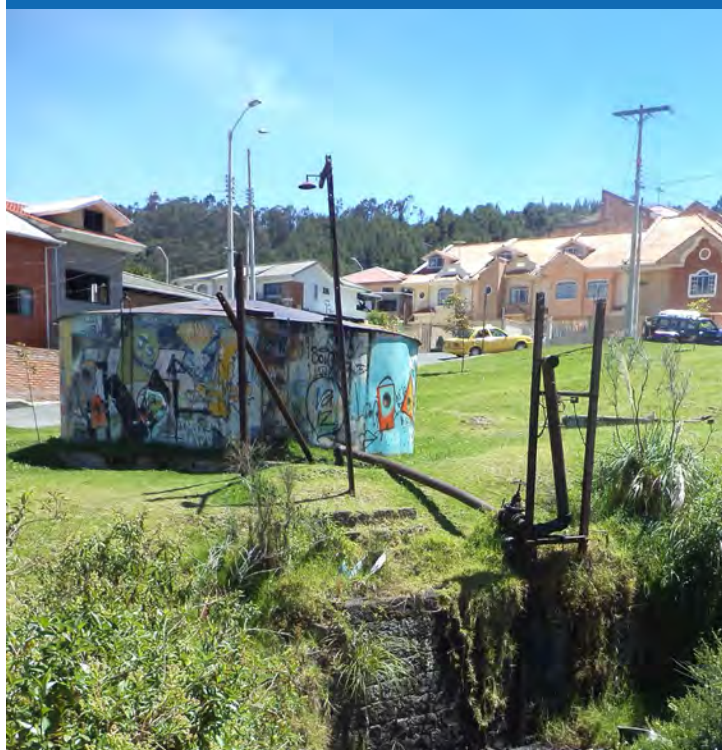
92. Fotografía: Tanque de almacenaje, ducto y quebrada de ingreso de ferrocarril.
