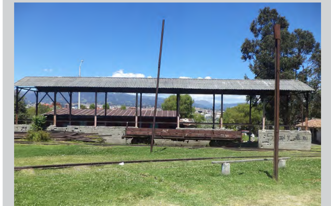
VISTA LATERAL DEL TALLER DE MECÁNICA
