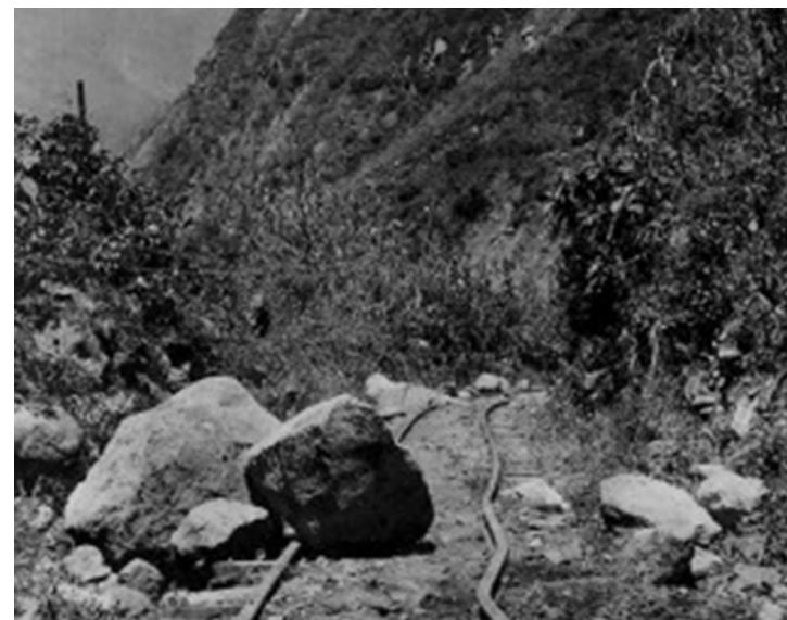
28. Fotografía: Rieles del ferrocarril dañados por derrumbes.
