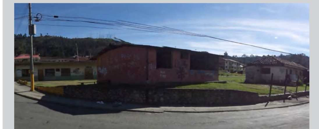
IMAGEN DEL ÁREA DONDE SE PLANTEA EL PABELLÓN
