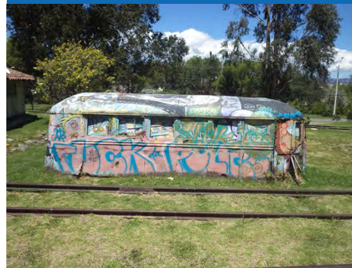
101. Fotografía: Estado actual de bloque 11.
