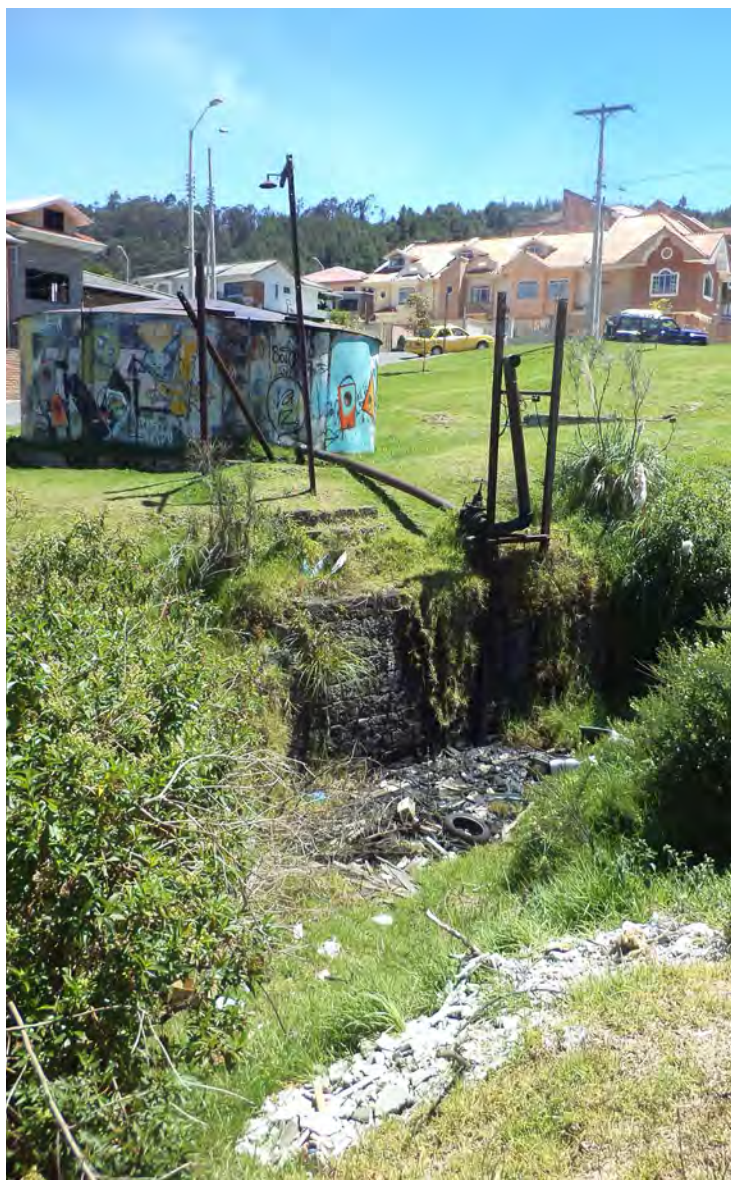
108. Fotografía: Derrame de aceite del tanque cilíndrico cerca de la quebrada.
