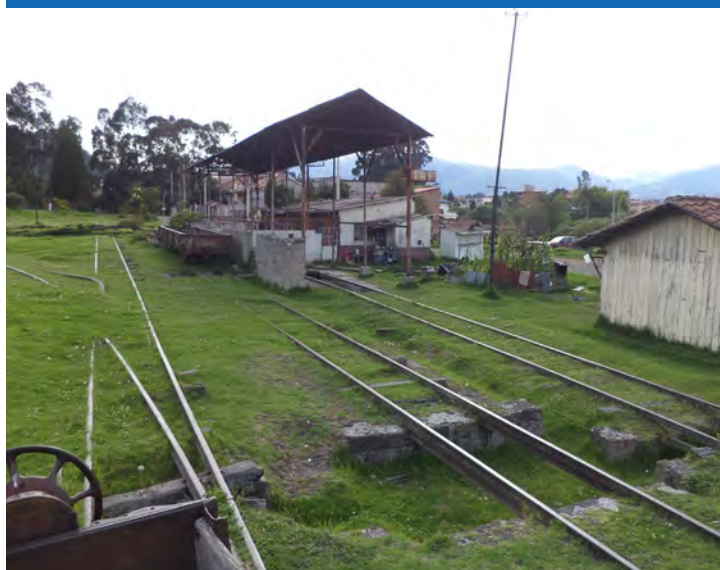
104. Fotografía: Vía Férrea sin durmientes y cubiertas por la capa vegetal.
