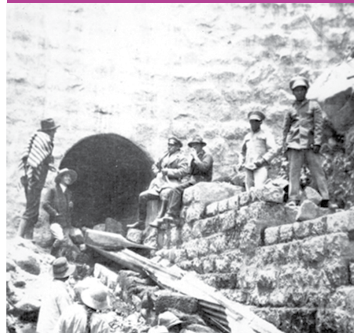
18. Fotografía: Trabajo en túneles.
