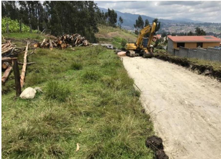
FIGURA 2.9: Excavación y Desalojo De Tierra
