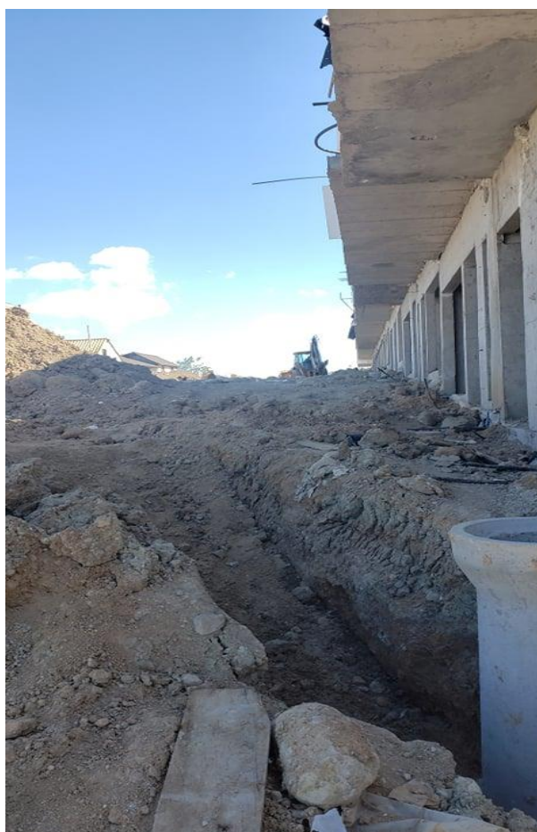
FIGURA 2.40: Instalación pozo Till
