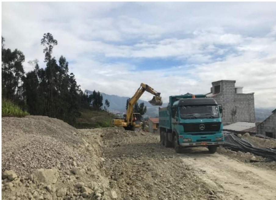
FIGURA 2.10: Excavación y Desalojo De Tierra
