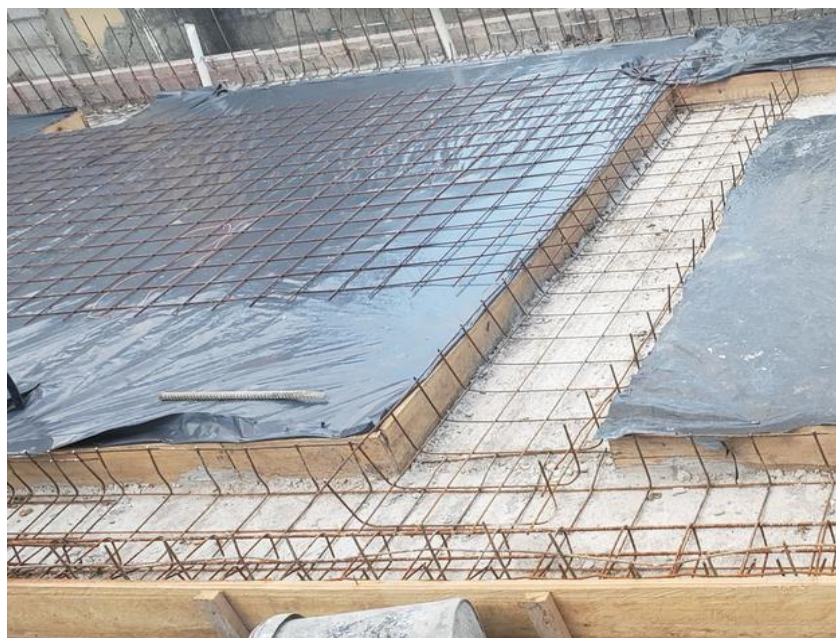
FIGURA 2.8: Encofrado De Madera Para Cimientos
