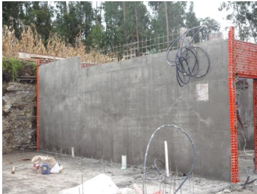
FIGURA 2.7: Paredes De Hormigón y Encofrado PVC
