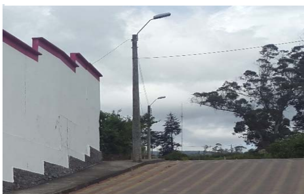
Figura 85: alumbrado eléctrico exterior terreno
