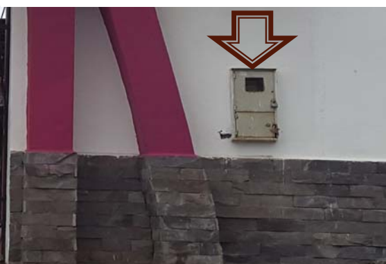
Figura 87: redes de agua potable del cementerio
