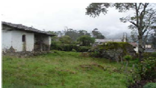
Figura 12: “casas junto a la roca”
