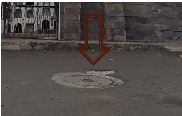
Figura 86: redes de alcantarillado del cementerio
