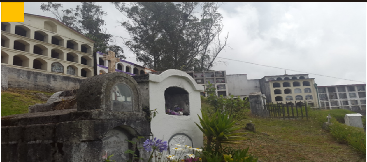
BLOQUES DE BOVEDAS EXISTETNES
