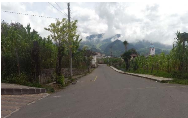
Figura 64 Estado vial de la calle Guayaquil
