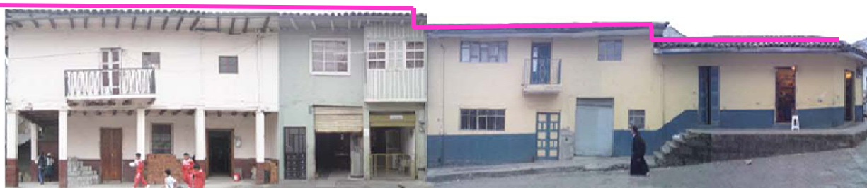
Figura 79: Ubicado en la calle Bolívar y 10 de Agosto. Fotografía obtenida del (GAD, SF2011, pág. 53)
