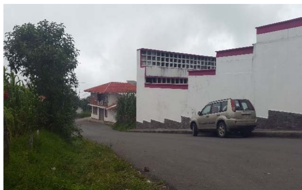
Figura 62 Estado vial de la calle Jaime Roldós.
