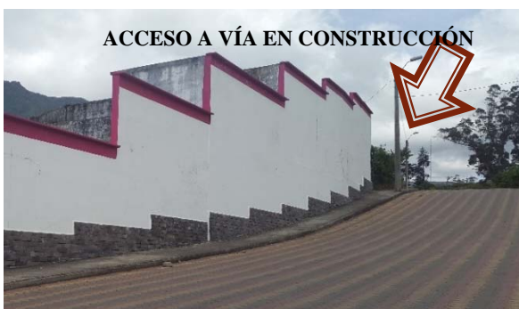
Figura 65 Estado vial de la calle Jaime Roldós
