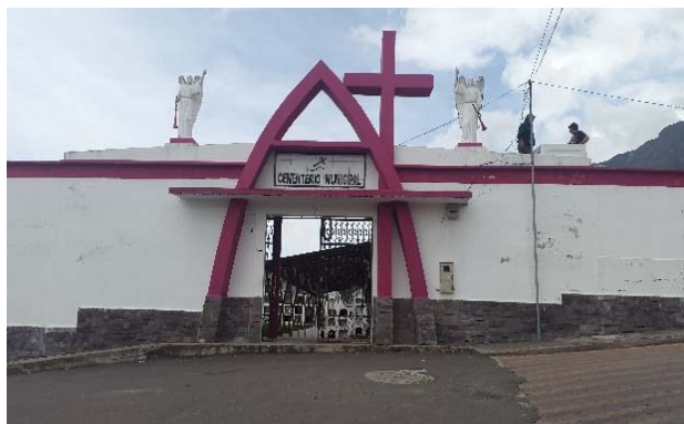
Figura 63 Estado vial de la calle Jaime Roldos
