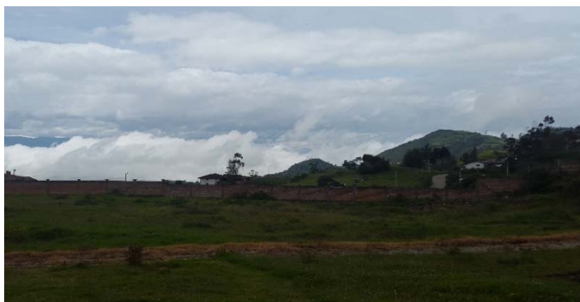
Figura 110: Sitio de intervención, San Fernando
