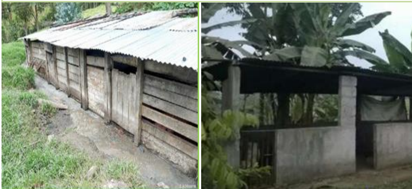
IMAGEN 38: Chanchera existente en la zona
