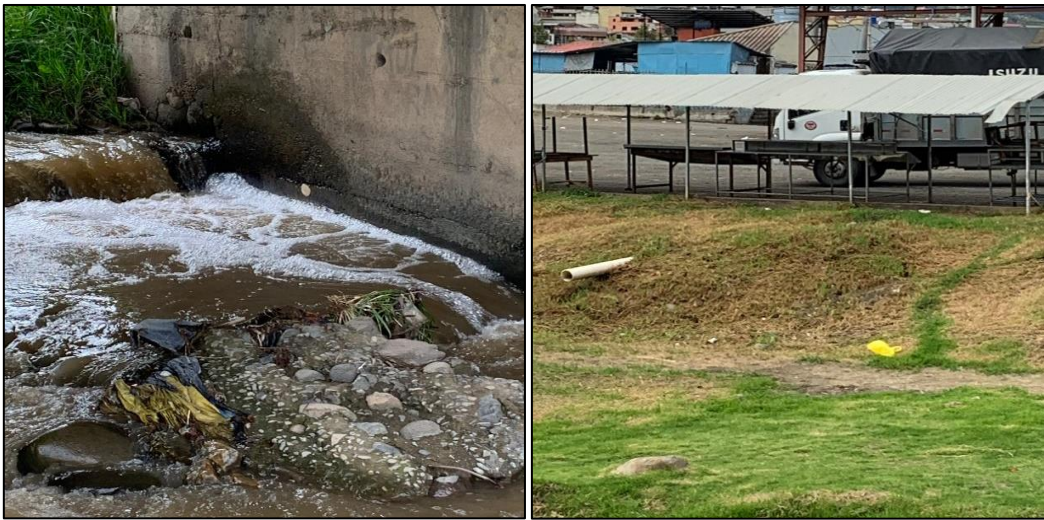
Figura 20: Descarga directa de agua residual al río Burgay
