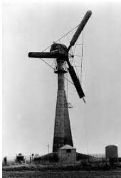
Figura 22: Aerogenerador tipo de configuración horizontal de Gedser
