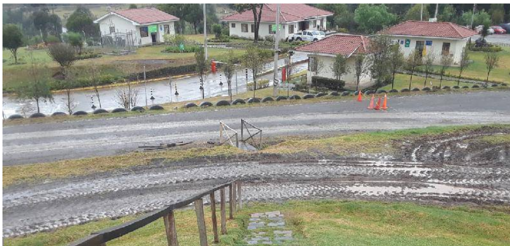
ILUSTRACIÓN 3.22: Zona administrativa, Relleno sanitario Pichacay
