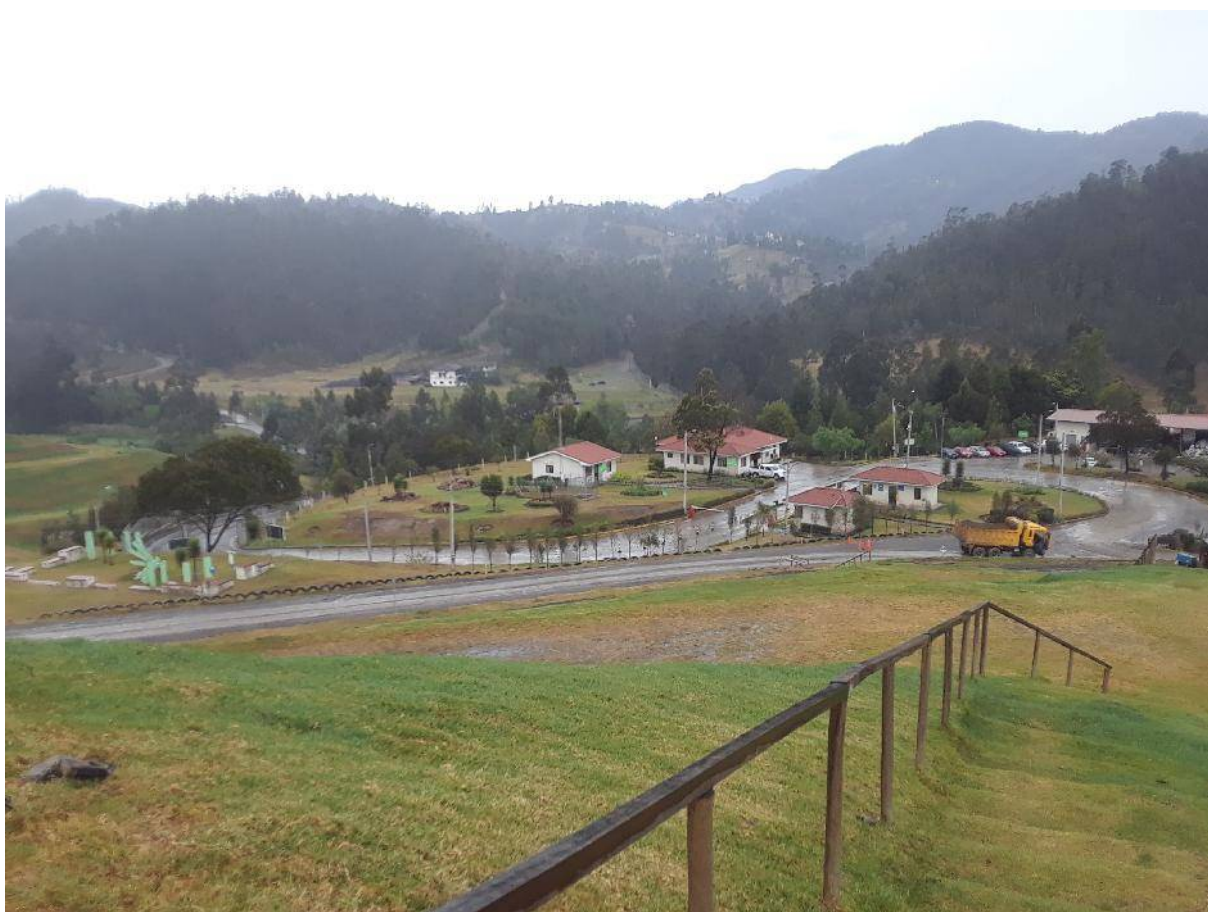
ILUSTRACIÓN 3.15: Vista desde terrazas de fase 1
