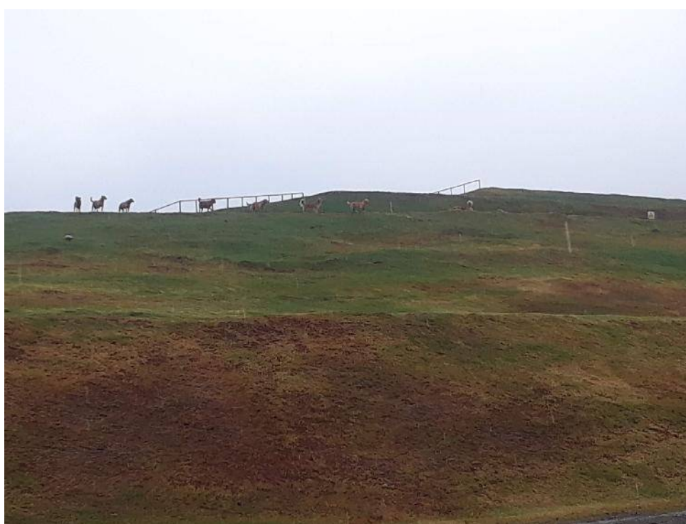
ILUSTRACIÓN 3.40: Relleno sanitario Pichacay Fase 1
