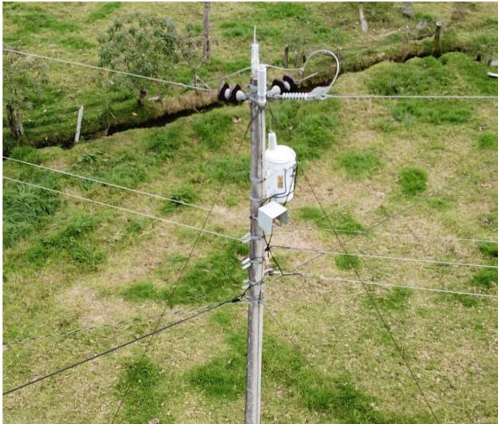
Ilustración 70: Fotografía de un poste del proyecto Cristal – Aguarongos tomada a 15 metros de altura. Fuente: Autor.
