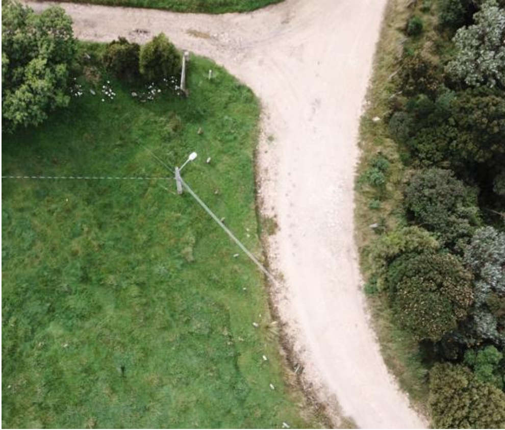
Ilustración 69: Fotografía de un poste del proyecto Cristal – Aguarongos tomada a 70 metros de altura. Fuente: Autor.
