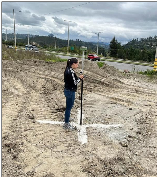
Figura 41. Equipo Róver nivelado sobre el punto de control para lograr una solución fija. Fuente: Autoría.
