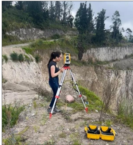
Figura 31. Planteo y nivelación de la Estación Total. Fuente: Autor.
