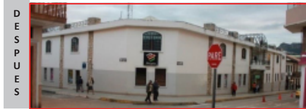
Figura 059. Centro Comercial Bartolomé Serrano Fuente: Autor de la tesis
