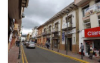
Figura 038. Imágenes Urbana Fuente: Autor de la tesis
