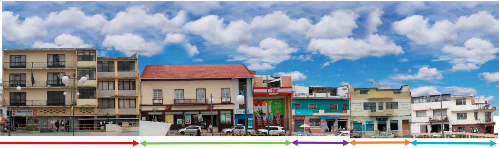
Figura 045. Perfil urbano de la Calle 3 de Noviembre Fuente: Autor de la tesis
