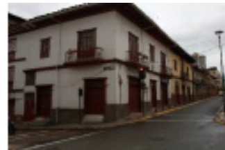
Figura 042. Imágenes Urbana Fuente: Autor de la tesis
