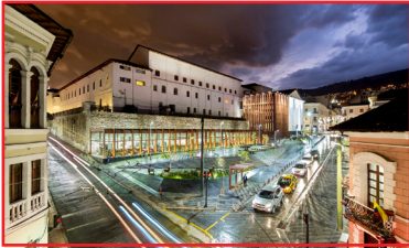
Figura 162. Plaza huerto San Agustín Fuente: Plataforma Arquitectura
