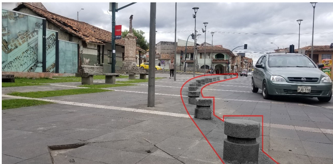
FIGURA 5.241: Protección contra el tráfico – Plaza El Rollo
