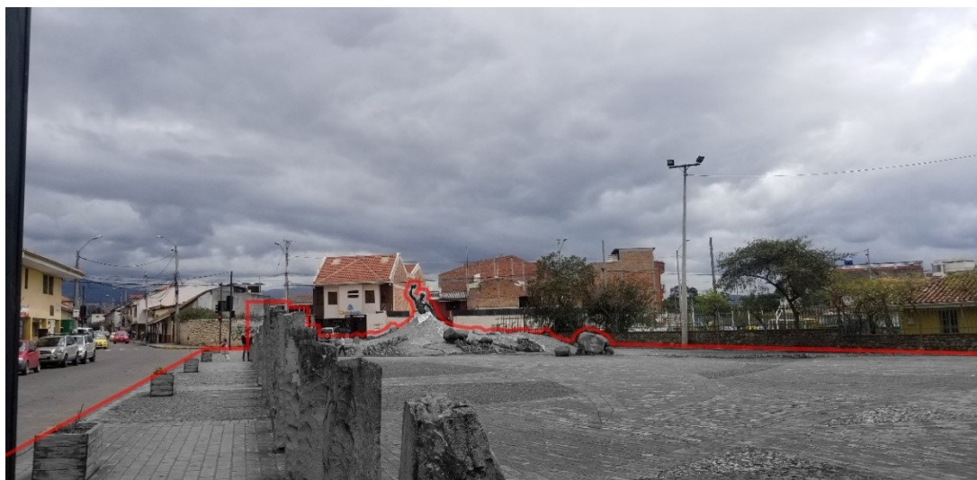
FIGURA 5.132: Espacios para caminar – Plaza del Herrero
