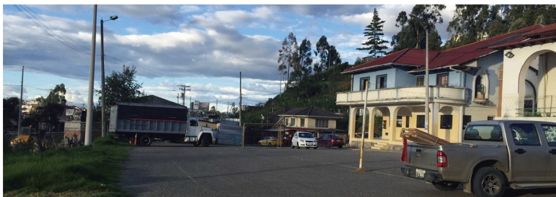
FIGURA 3.1: Estado actual de la plaza Carmen de Guzho
