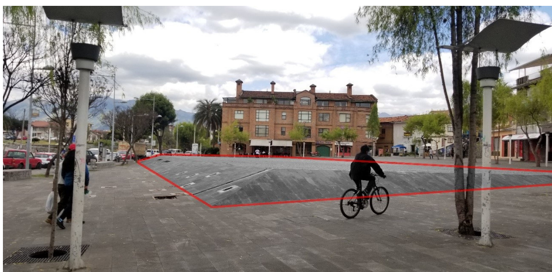
FIGURA 5.12: Espacios para caminar – Plaza Otorongo
