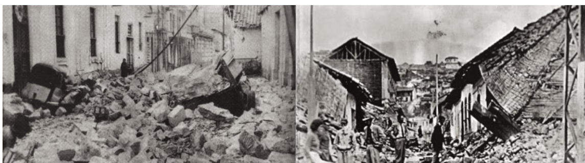
Figura 3: Destrucción ocasionada por el terremoto de Ambato 1949.
