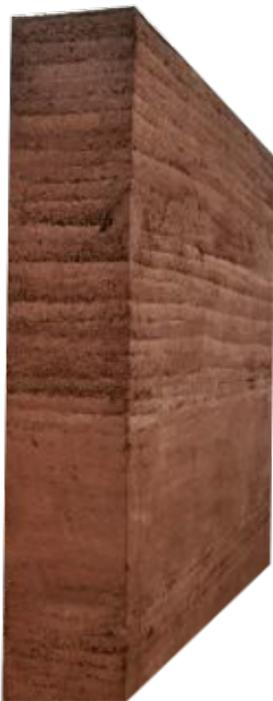
Este método consiste en la elaboración de muros con tierra arcillosa húmeda, la misma que se compacta en un encofrado con diferentes estratos. Comúnmente a esta técnica se le agregan aditivos naturales como lo son la paja o guano, aportando de esta manera mayor estabilidad al sistema.
