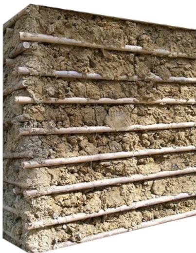
Este sistema estructural de mampostería consiste en la fabricación de paredes partiendo desde un armazón de guadua, bambú o madera, la misma que viene recubierta con un revoque de mortero de cemento.
