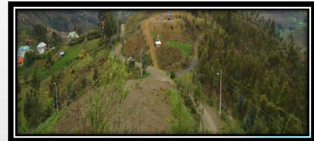
Foto 3.6 Tendido eléctrico de la Comunidad de San Miguel de Pucacruz
