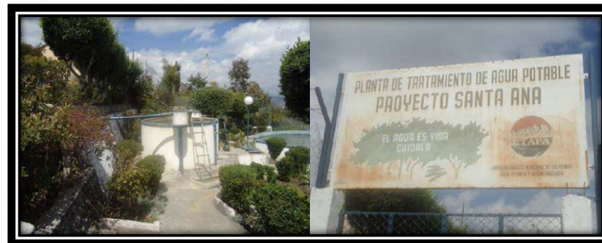
Imagen 1.17 Planta de agua potable de la Parroquia Santa Ana
