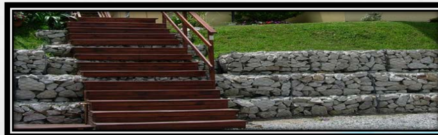
Imagen 4.4 Muro de Gaviones
