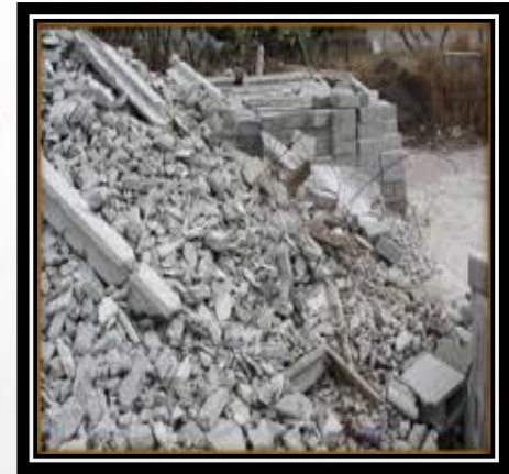
Imagen 2.16 Hormigón en escombros
