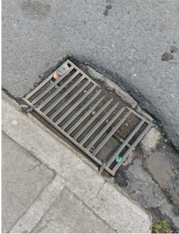
*Figura 48. Sumidero taponado del cual se obtuvo la muestra de material a ensayar.*
