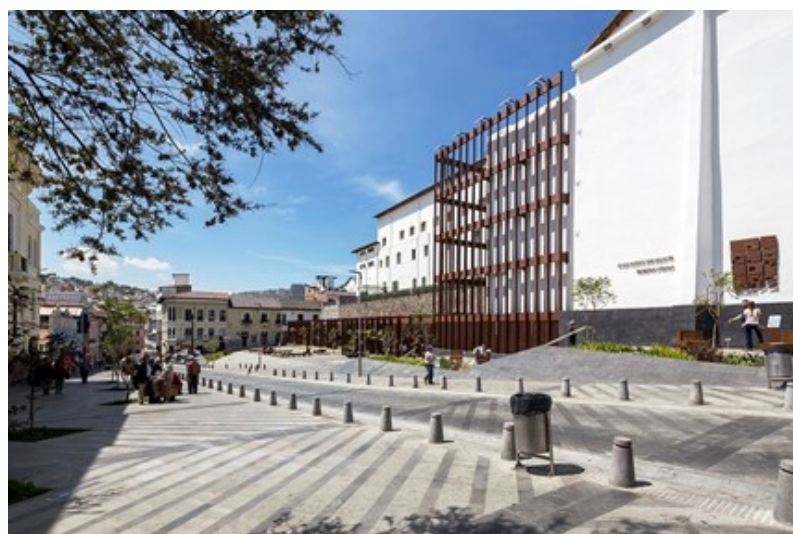
FIGURA 2.65: Protección para la circulación vertical del Convento de San Agustín. Fuente: Plataforma Arquitectura
