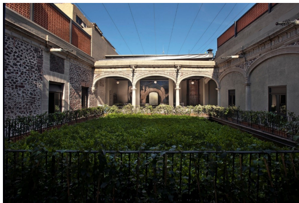
FIGURA 2.146: Vista desde el patio interior principal. Compaginación de elementos nuevos y viejos. Fuente: Plataforma Arquitectura
