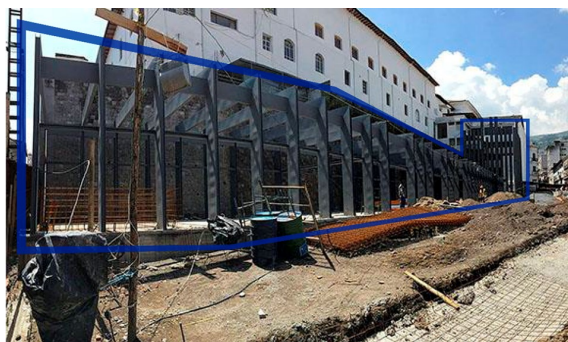
FIGURA 2.80: Montaje de la estructura metálica. Fuente: Plataforma Arquitectura
