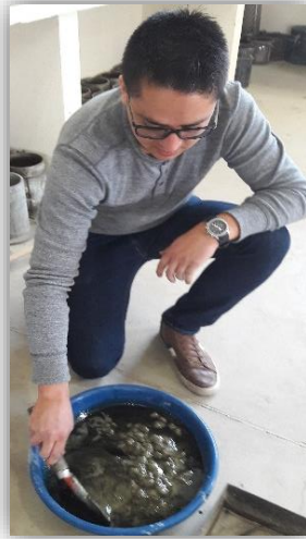
Figura 47. Mezclado del Hormigón.
