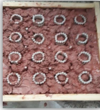
Figura 57. Vertido del Hormigón en el Molde con Fibra Óptica.
