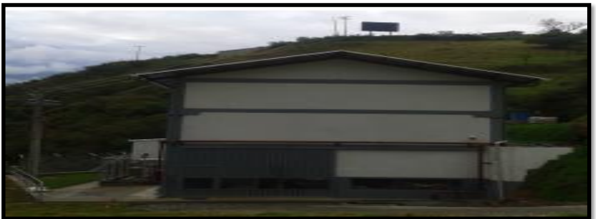
Figura. 16 Edificio de la minicentral hidroeléctrica Gualaceo Fuente: (ELECTRO GENERADORA DEL AUSTRO, s.f.)
