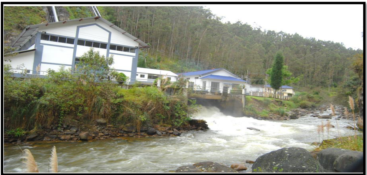
Figura. 9 Esquema de una central de pie de presa Fuente: (ELECTRO GENERADORA DEL AUSTRO, s.f.)
