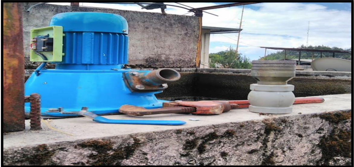
Figura. 53 Instalación del cono de presión Fuente: (AUTORES)
