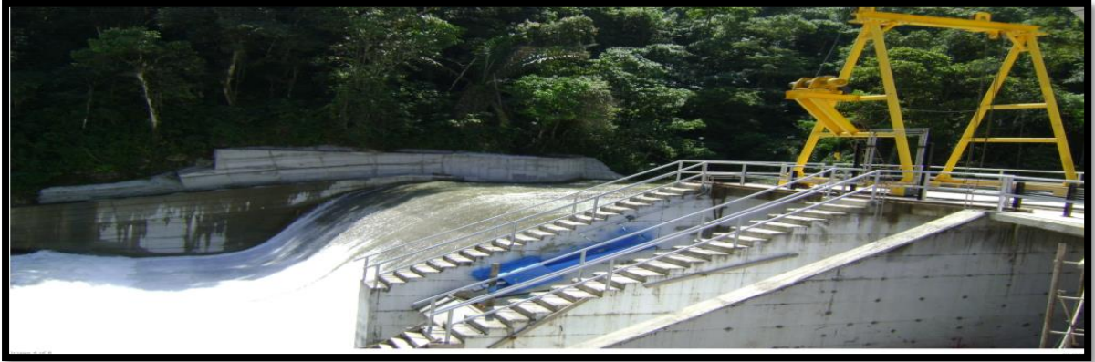
Figura. 12 Azud Central Ocaña I Fuente: (ELECTRO GENERADORA DEL AUSTRO, s.f.)
