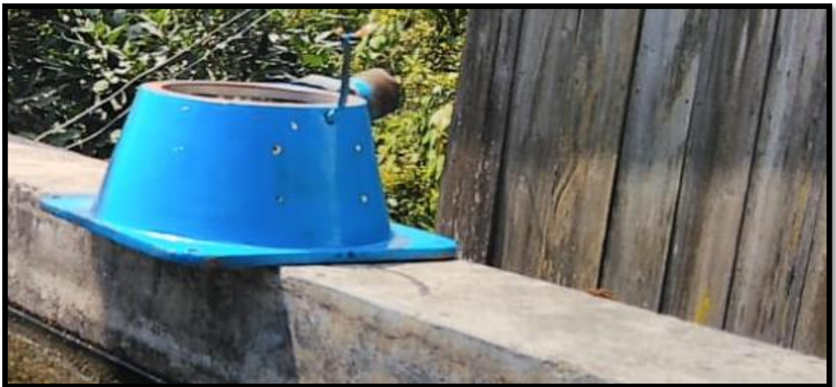
Figura. 52 Instalación de la base de la turbina Fuente: (AUTORES)
