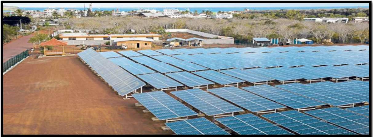
Figura. 3 Proyecto Fotovoltaico Puerto Ayora 1.5 MWp Fuente: (Ministerio de Electricidad y Energia)
