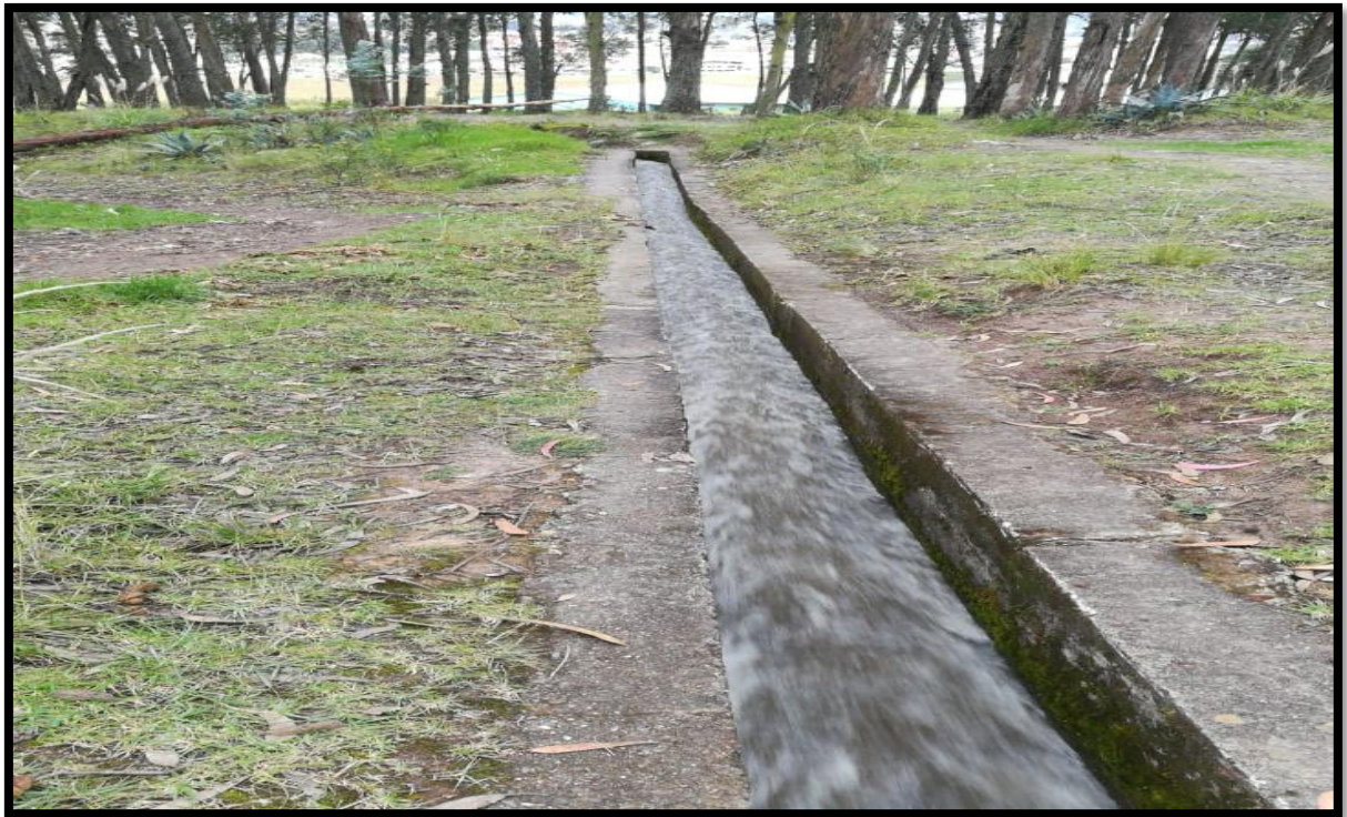
Figura. 28 Canal de riego en Ricuate-Cuenca Fuente: (AUTORES)
