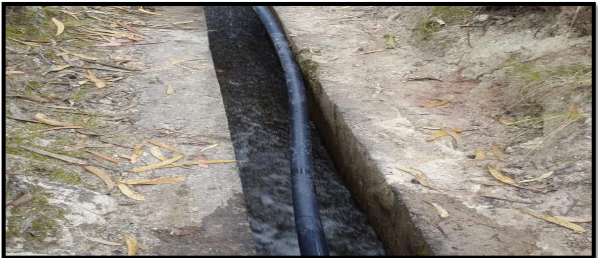
Figura. 50 Instalación de la tubería Fuente: (AUTORES)
