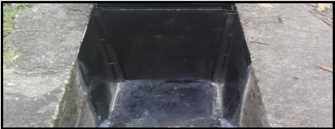
Figura. 46 Instalación de la rejilla Fuente: (AUTORES)
