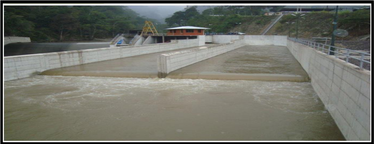
Figura. 13 Toma de agua Central Ocaña I Fuente: (Minicentrales Hidroeléctricas, 2006)
