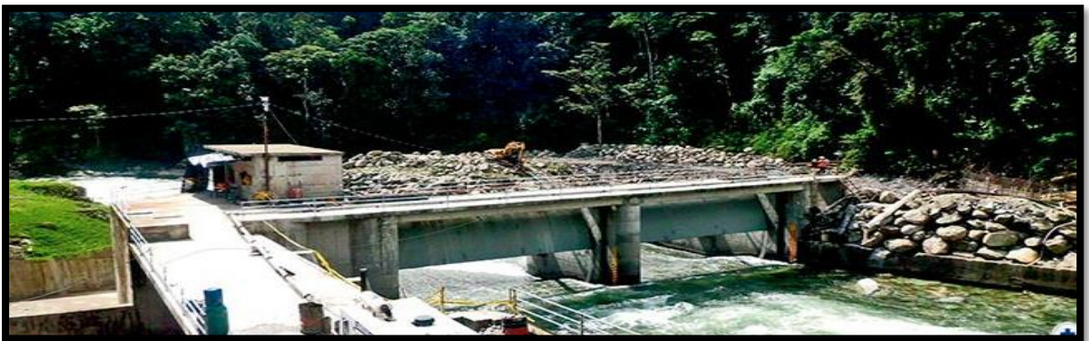
Figura. 5 Central hidroeléctrica TOPO 30MW Tungurahua - Ecuador. Fuente: (ARCONEL, s.f.)
