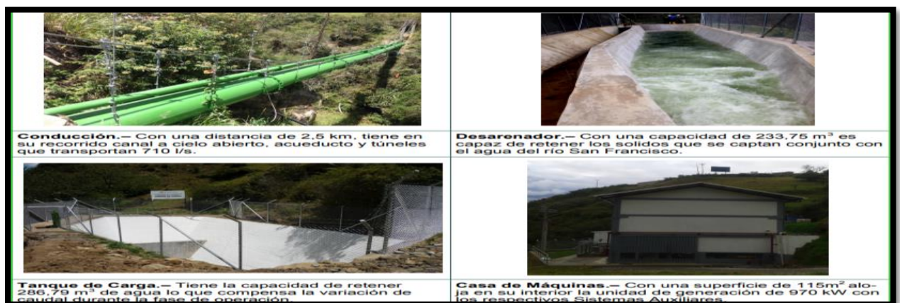
Figura. 6 Mini central hidroeléctrica 970 kW Gualaceo-Ecuador Fuente: (Ministerio de Electricidad y Energía)
