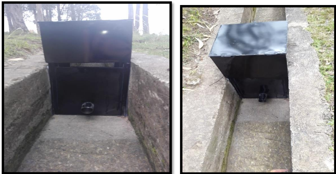
Figura. 48 Instalación de la cámara de presión Fuente: (AUTORES)
