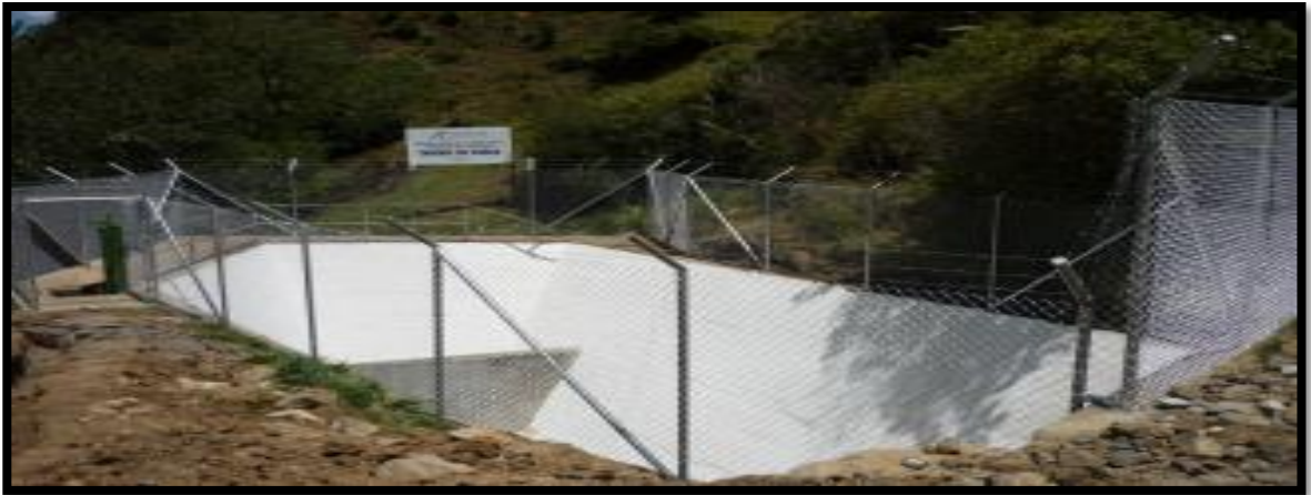
Figura. 15 Minicentral hidroeléctrica Gualaceo Tanque de carga Fuente: (ELECTRO GENERADORA DEL AUSTRO, s.f.)
