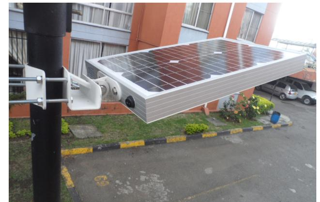
Figura 60. Lámpara LED con panel solar integrado
