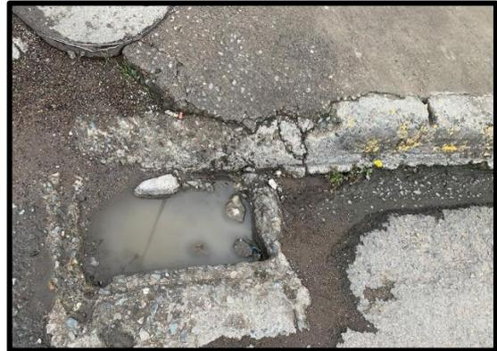
*Ilustración 21: Sistema De Drenaje En Mal Estado.
