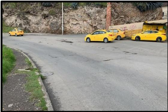
*Ilustración 29: Inexistencia De Líneas De Demarcación.
