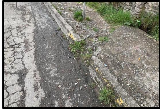
*Ilustración 19: Falta De Mantenimiento En El Sistema De Drenaje.
