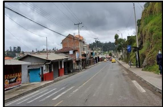
*Ilustración 30: Líneas De Demarcación En Mal Estado.
