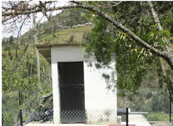
Fotografía 16. Vista panorámica caseta de cloración
