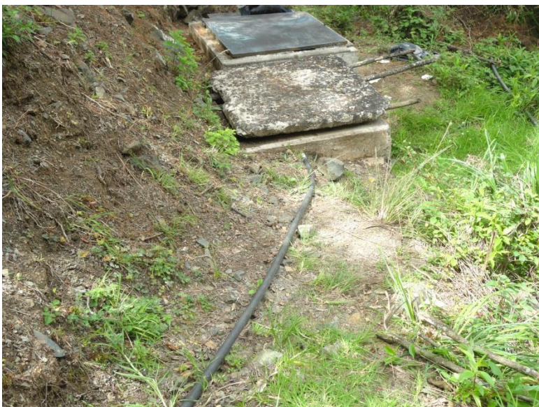
Tanque de Captación Azulcaca
