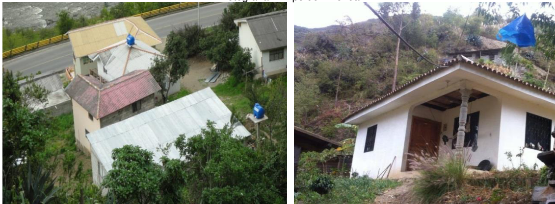
Fotografía 4. Tipo de vivienda
