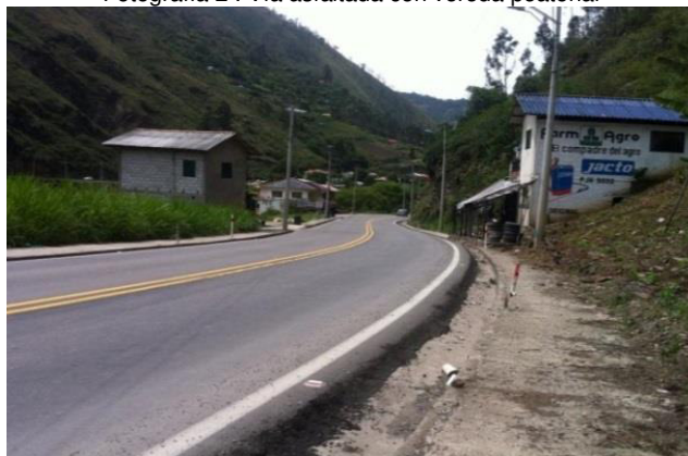
Fotografía 2 . Vía asfaltada con vereda peatonal
