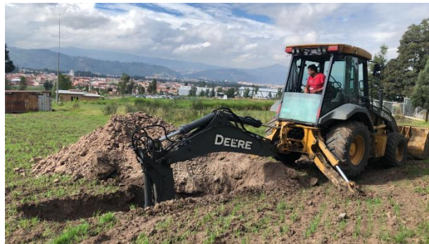
Extracción de calicatas punto 1
