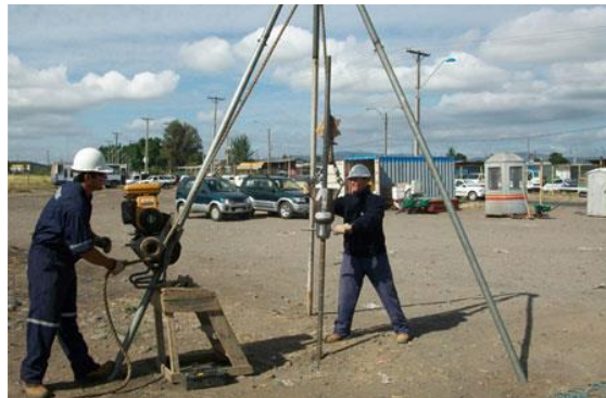
Ilustración 9: Ensayo de penetración estándar Fuente: Laboratorio de Viña
