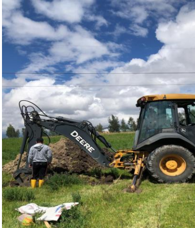
Extracción de calicatas punto 3
