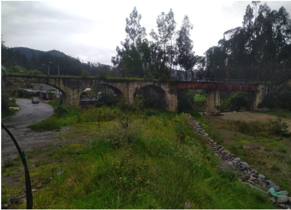
Ilustración 44. Reconocimiento del puente San José. Fuente fotográfica: propia.
