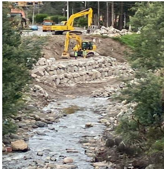
Ilustración 1. Espigón provisional en el cauce del río Burgay. Fuente: Propia.
