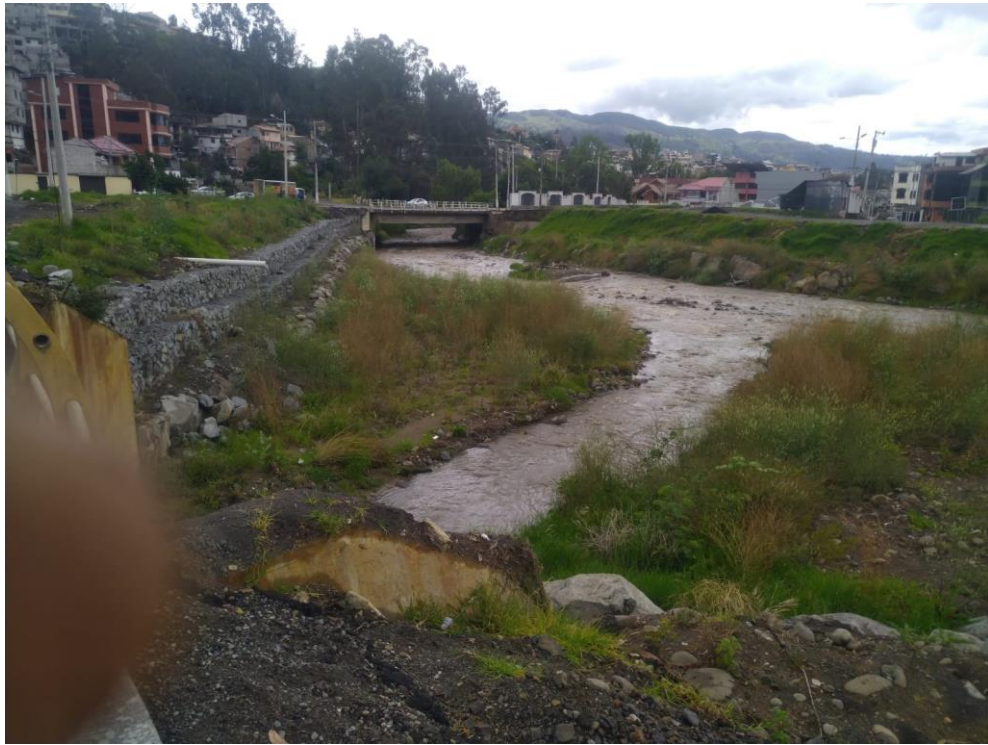
Ilustración 46. Reconocimiento del aporte del río Tabacay, mercado Sucre. Fuente fotográfica: propia.
