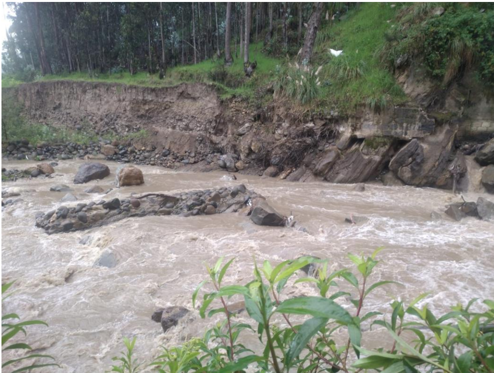
Ilustración 45. Daños en los límites del río por fuertes crecidas. Fuente fotográfica: Propia.
